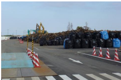
浪江町請戸地区仮置場での災害廃棄物等の搬入状況 (平成26年10月)
