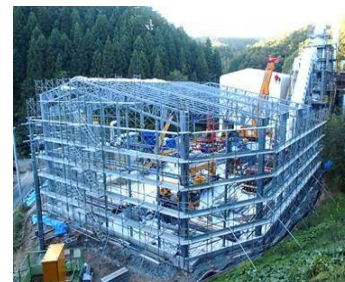
川内村における 仮設焼却施設の建設状況 (平成26年10月)
