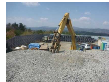
広野町仮置場における資材物(仮置き状況)(4月8日)
