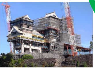
復旧中の熊本城
