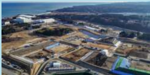
中間貯蔵施設(大熊②工区周辺)
