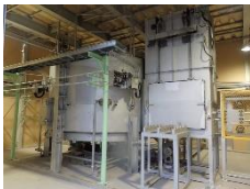
<Li-ion電池リサイクル設備>
