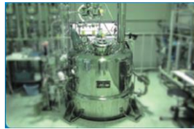
<バイオマスプラスチック製造設備>
