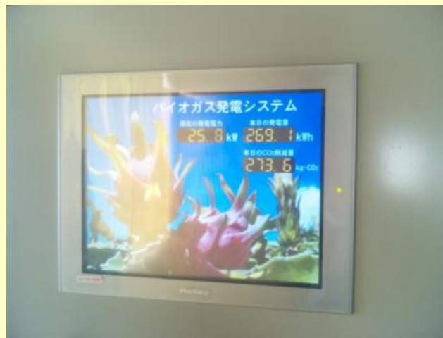
プラント設備制御盤
