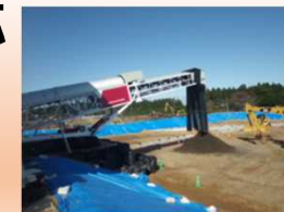
中間貯蔵施設 土壌貯蔵施設
