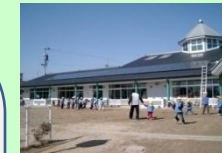
市民出資による 太陽光パネル設置
