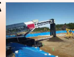
中間貯蔵施設 土壌貯蔵施設
