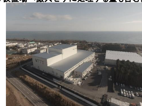
大熊町の仮設焼却施設
