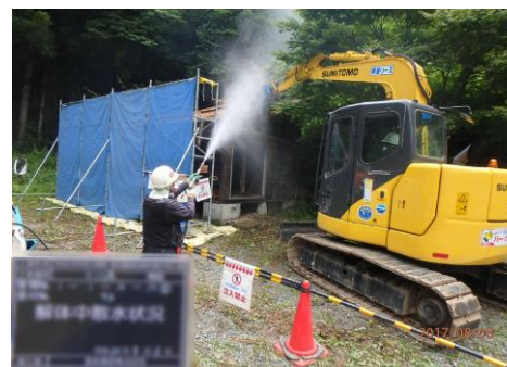
被災家屋等の解体の様子
