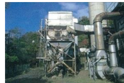
老朽化した廃棄物処理施設の更新
