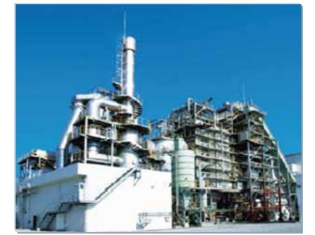
日本の技術を活用して建設された産業廃棄物焼却施設(台湾)
