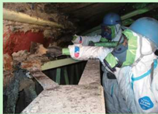
吹付け石綿の除去作業の様子
