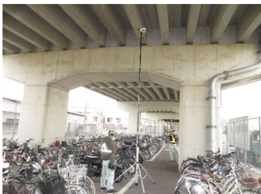
●ロボットカメラ点検
