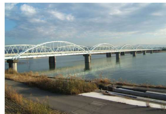
六十谷水管橋（破損前）
