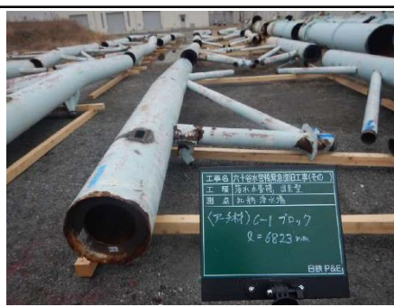
落水水管橋 出来形 加納浄水場(仮置き) アーチ材 C-1ブロック L=6823mm
