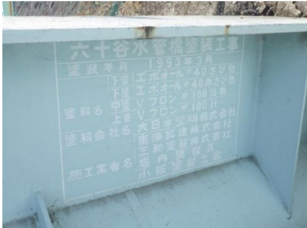
図 既設塗装(フッ素樹脂塗装)
