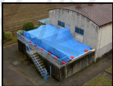
【筑西市 成田浄水場 着水井 覆蓋】
