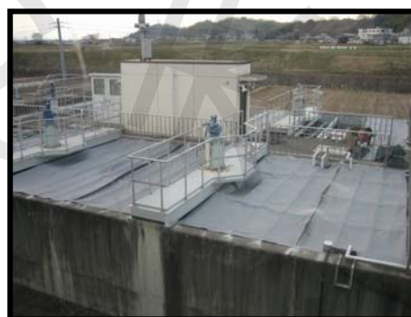
【高崎市 岩崎浄水場 ろ過池 覆蓋】
