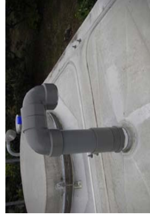
7-2改善後 管端部に下り幅を設ける
