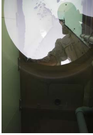
4-2改善前 水槽内部の汚れ、沈積物
