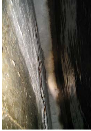
4-14改善前 RC水槽の壁面等の劣化
