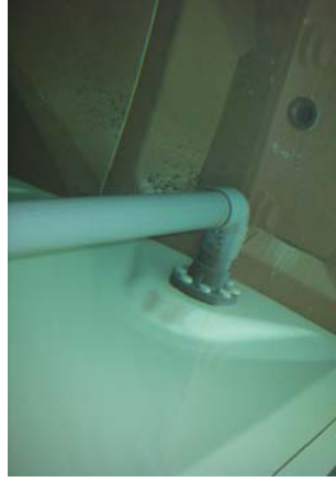
4-3改善前 水槽内部の沈積物
