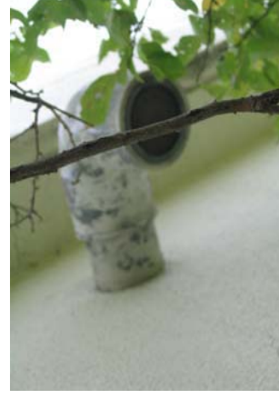
7-4改善後 管端部に下り幅を設ける
