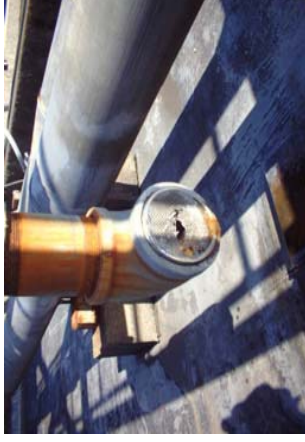
6-6改善前 管端部防虫網の破損
