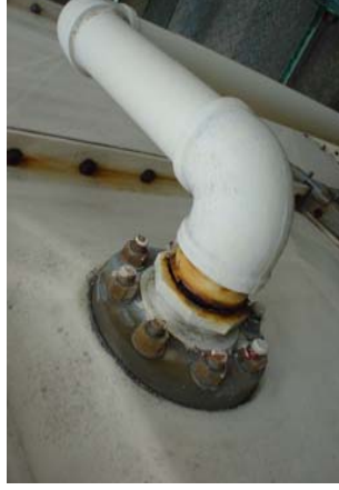
6-5改善前 管接合部の腐食
