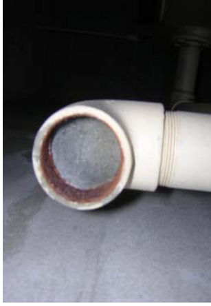
7-1改善前 管端部が横向きのため埃等の混入
