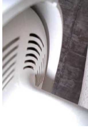
7-18改善前 網目が虫等の侵入を防ぐのに不十分 7-19改善後 防虫網の取替え
