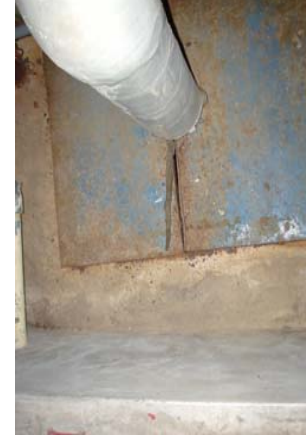
2-19改善前 揚水管挿入部の隙間
