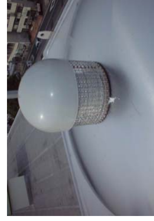
7-24その他 鳥のつつきによる破損防止
