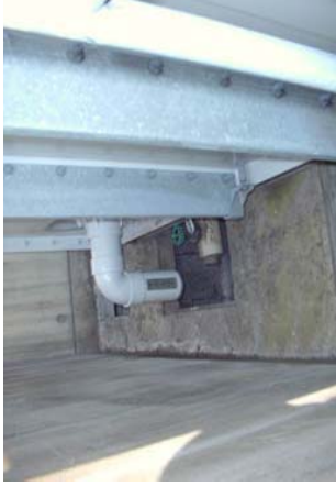
8-1改善前 管端部が排水溝へ直接連結
