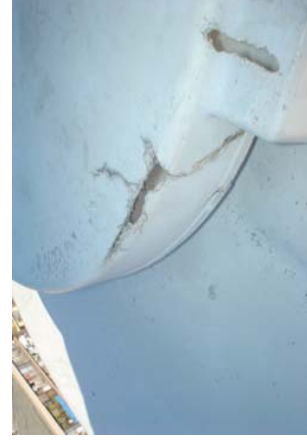
5-26改善後 マンホール都全体にクッション材の取付け 5-27改善前 マンホール部破損
