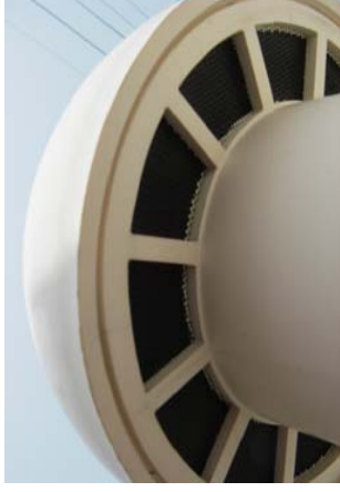
7-18改善前 網目が虫等の侵入を防ぐのに不十分 7-19改善後 防虫網の取替え
