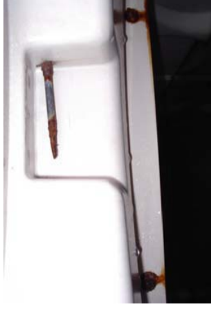
5-5改善前 蝶番軸の腐食、破損
