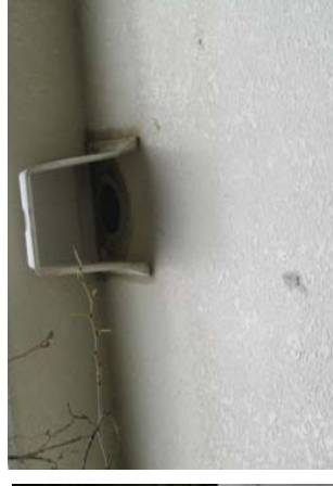
7-3改善後 管端部にカバーの設置
