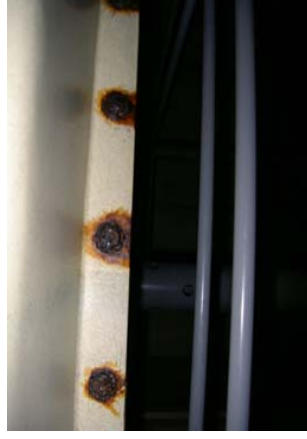
4-16改善前 内部構造物の腐食
