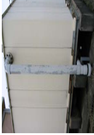
6-4改善後 管端部に下り幅を設ける
