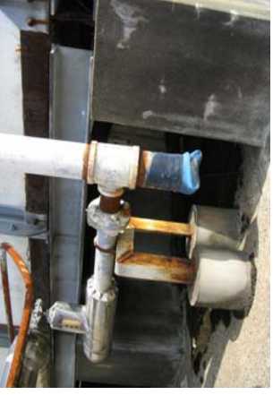
6-11改善後 管端部を防虫網で覆う
