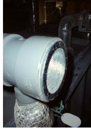
6-10改善後 正常な防虫網の取り付け
