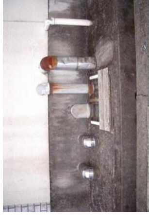
6-3改善後 管端部に下り幅を設ける
