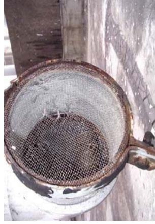
6-7改善前 管端部防虫網の破損
