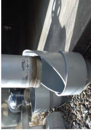
6-14改善後 排水受けを切り空間を設ける
