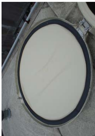
5-24改善後 ハッキンの取付け
