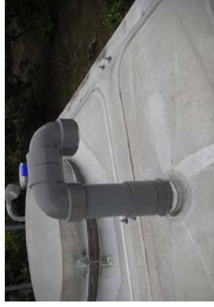
7-2改善後 管端部に下り幅を設ける
