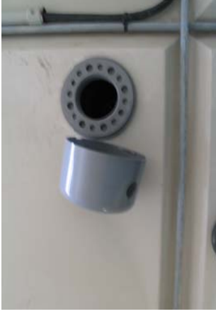
2-14改善前 水位電極(未使用)がなく開放状態
