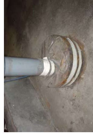
2-20改善後 開放部をビニールシート等で被い密閉
