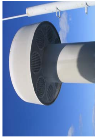
7-9改善後 正常な状態
