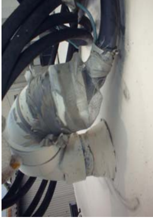
2-26改善後 ビニールシート等で被う
