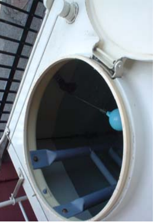
5-23改善後 ハッキンの交換
