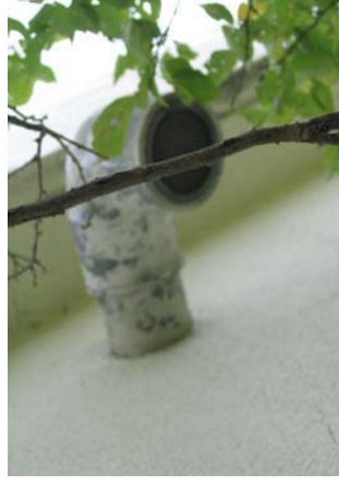
7-4改善後 管端部に下り幅を設ける
