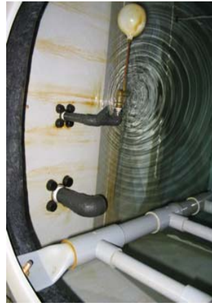
4-22改善後 管端部を切り吐出口空間を設ける
