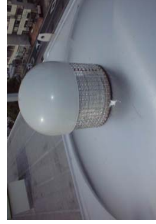
7-24その他 鳥のつつつきによる破損防止
