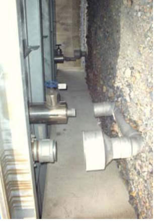
8-6改善後 管端部を切断し排水受けと切り離し
