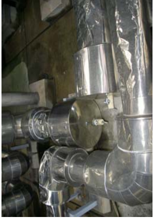
9-2改善後 連通管の切り離し
