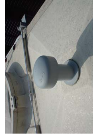
7-8改善後 正常な状態
