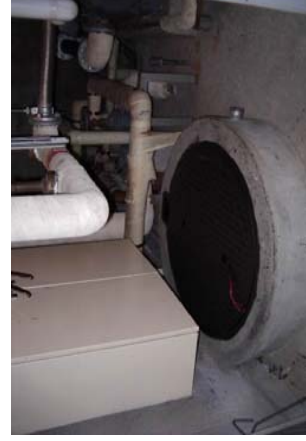
5-28改善後 枠部の排水ドレンの設置
