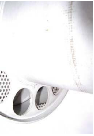
7-14改善前 防虫網の破損
