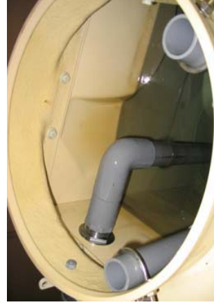
4-21改善前 流入管の吐出口空間なし
