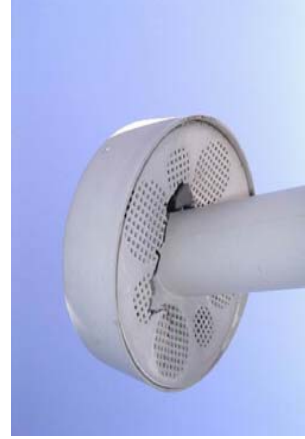
7-7改善前 通気管破損
