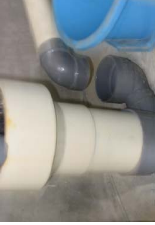
8-7改善後 管端部を切断し排水受けと切り離し
