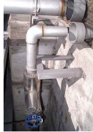
8-4改善後 管端部を切断し排水受けと切り離し
