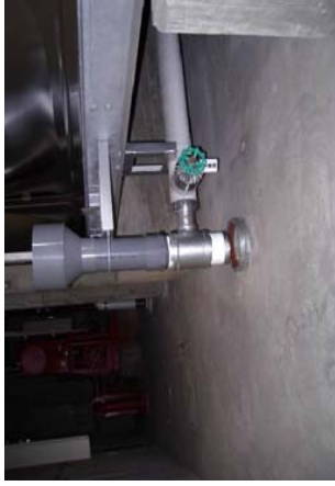
8-5改善後 管端部を切断し排水受けと切り離し
