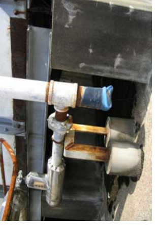
6-11改善後 管端部を防虫網で覆う
