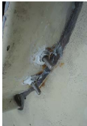
2-10改善後 隙間、穴部分をコーキング等で埋める
