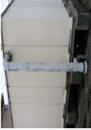
6-4改善後 管端部に下り幅を設ける
