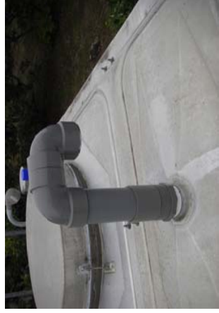
7-2改善後 管端部に下り幅を設ける
