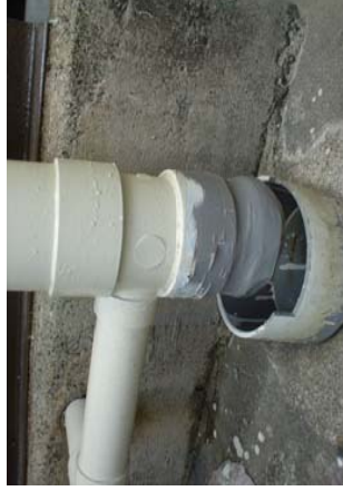
6-15改善後 排水受けを切り空間を設ける
