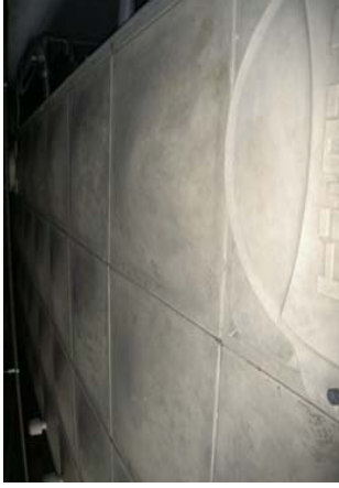
3-4改善後 水槽上部を水が溜まらない形状に改善
