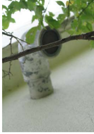
7-4改善後 管端部に下り幅を設ける
