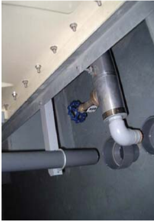
6-13改善後 排水口空間がある状態
