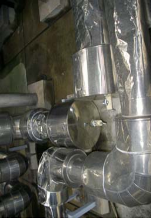
9-2改善後 連通管の切り離し
