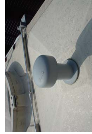
7-8改善後 正常な状態
