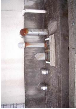
6-3改善後 管端部に下り幅を設ける
