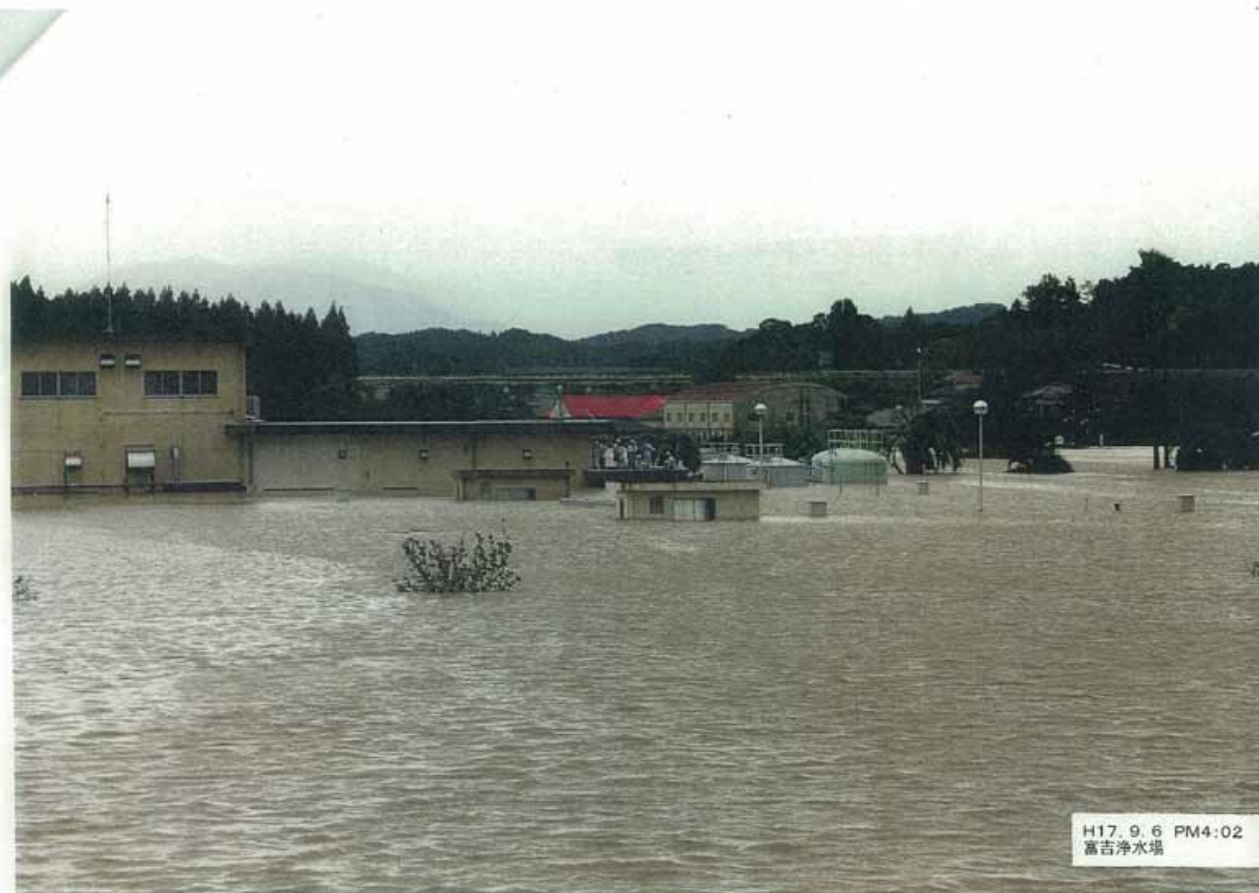
洪水によって冠水した富吉浄水場（宮崎市上下水道局） （H17台風第14号による洪水）
