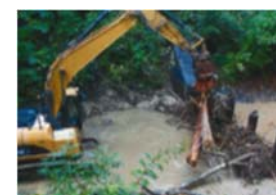
流木捕捉式治山ダムに堆積した流木の除去や林外への搬出・処理
