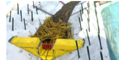
流木捕捉式治山ダムにかかる効果検証等の実証事業
