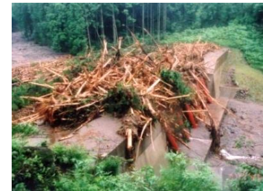
流木捕捉式治山ダムの設置
