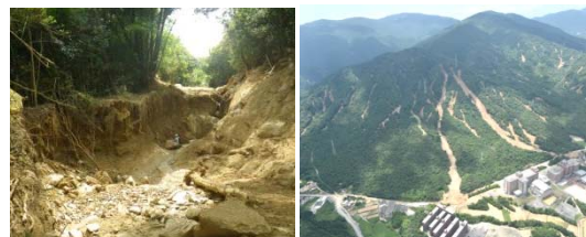
広島県東広島市の被災状況
