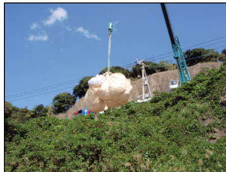
クレーンによる運搬（長崎県・志多留）
