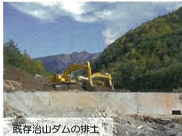
既存治山ダムの排土
