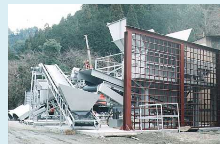
破碎切断施設
