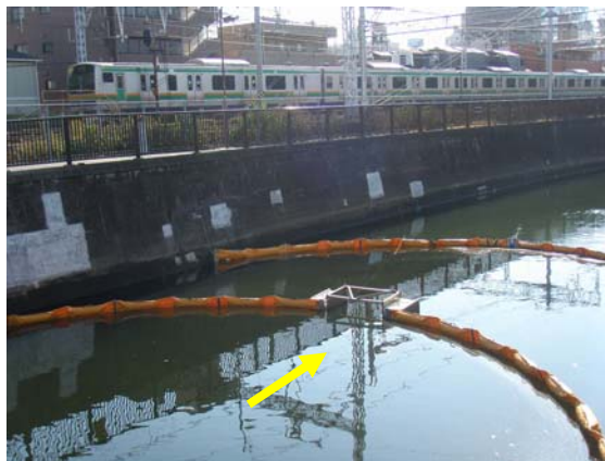
設置中のオイルフェンス (B-1)
