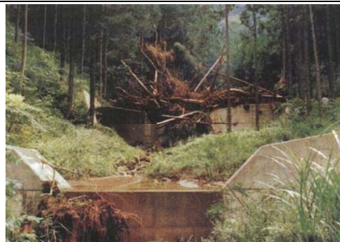
治山ダムが流木を防いだ例（1984. 8）
