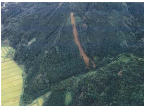
災害発生状況（1984. 8）
