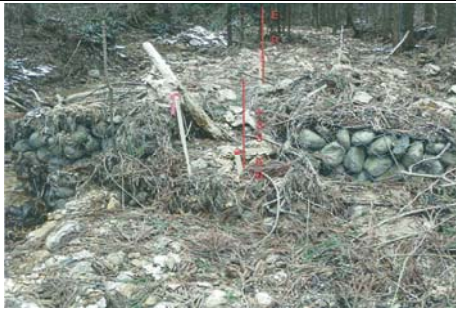
床固工（竣工前）
