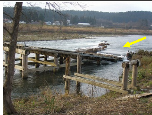
ごみ補足施設（真室川）
