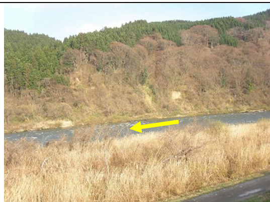
最上川 (26. 6km : 崩落しそうな右岸)
