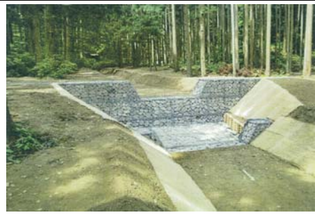
床固工（完成時：大型フトン籠）
