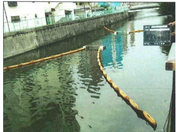
設置中のオイルフェンス (B-2)
