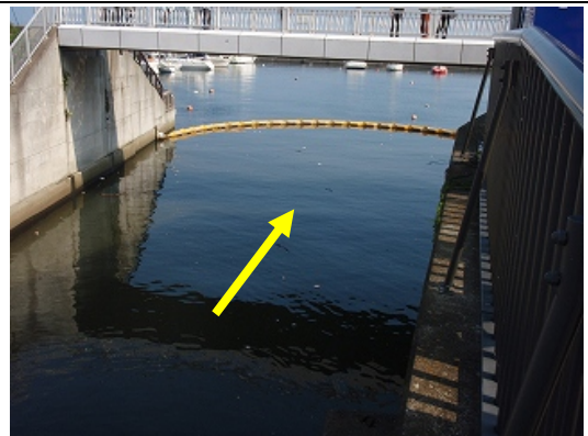
設置中のオイルフェンス
