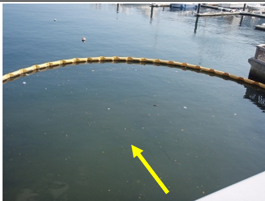
設置中のオイルフェンス
