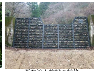
既存治山施設の補修
