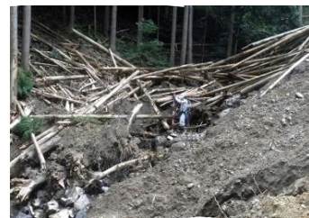
溪流内に堆積した危険木等の除去
