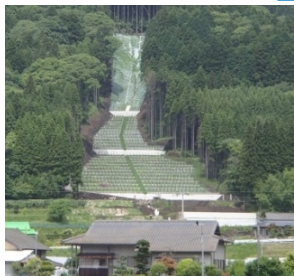
豪雨により発生した山腹崩壊地の復旧
