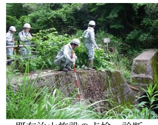
既存治山施設の点検・診断
