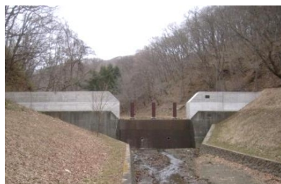
治山ダムへの流木止施設の付加
