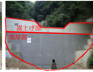
既存治山施設の機能強化
