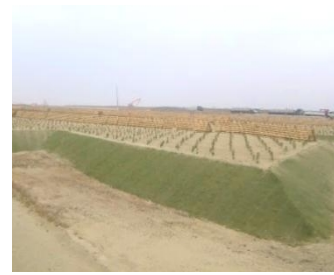
東日本大震災により被災した海岸防災林の復旧・再生
