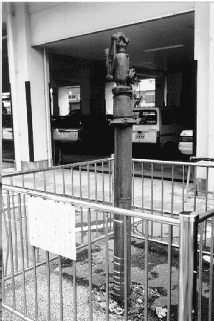
東京都葛飾区の被害事例：井戸の抜け上がり状況 http://www.env.go.jp/water/jiban/directory/13tokyo/kantouminami/p13-1.html
