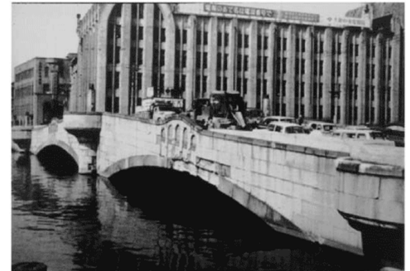
写真1 大阪市内の橋梁の沈下
