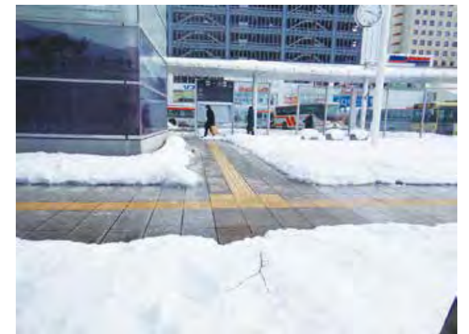
融雪範囲の平面図（色付部分が融雪範囲）。導入後の写真を比較すると、図面通り融雪されていることが分かる
