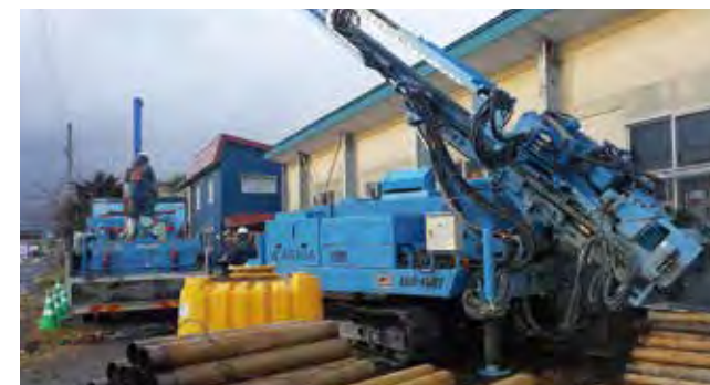
地中熱のボーリング調査
