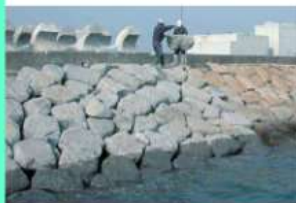
人工石材を用いた港湾防波工事
