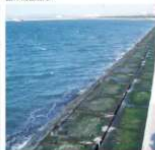
鉄鋼スラグ水和固化体製ブロックを用いた護岸補強工事
