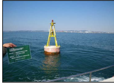
地点 7 設置箇所
