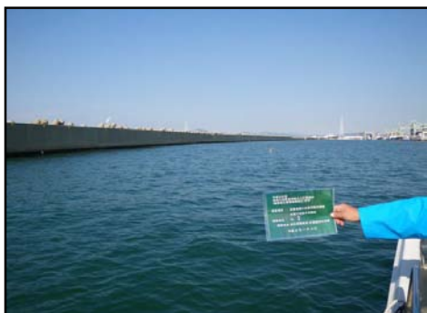
地点 5 設置箇所(北方向状況)
