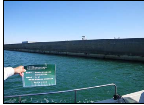
地点 2 設置箇所
