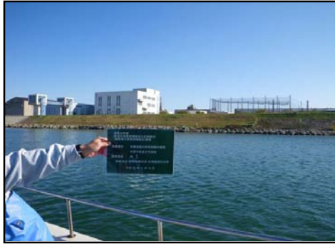
地点 1 設置箇所
