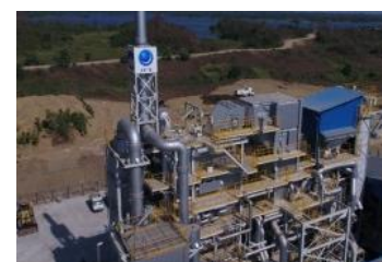
(例) 廃棄物発電施設
