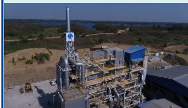
廃棄物発電施設
