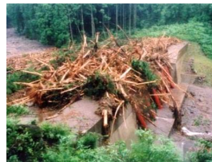
流木捕捉式治山ダムの設置
