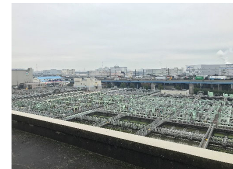
西浦下水処理場
