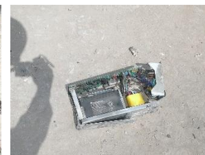
燃えていないUPS
