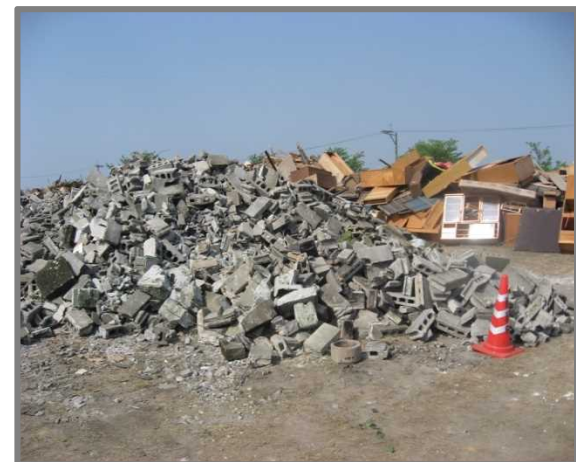
仮置状況(コンクリートブロック)
