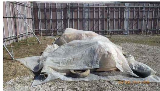
仮置場で廃石膏ボードを保管する場合、**降雨により水濡れしない保管場所あるいはブルーシート等による被覆や表流水との接触を避けるための嵩上げ**などに配慮する
