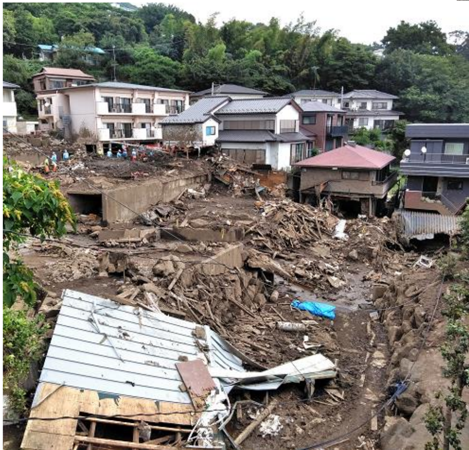
環境省撮影 伊豆山 土石流現場 (令和3年7月15日時点)
