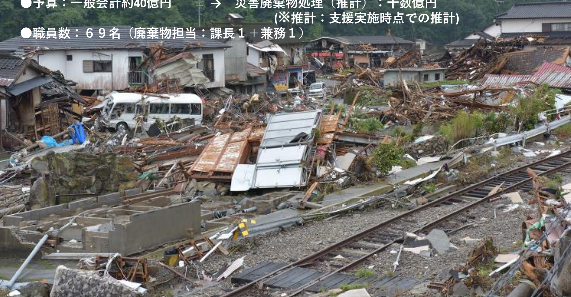
図6 氾濫流による建物等の破壊・流失その1(写真番号:N81_8532) 球磨村渡地区。すぐ奥の斜面の麓が球磨川本流で、左が上流側、右が下流側。
