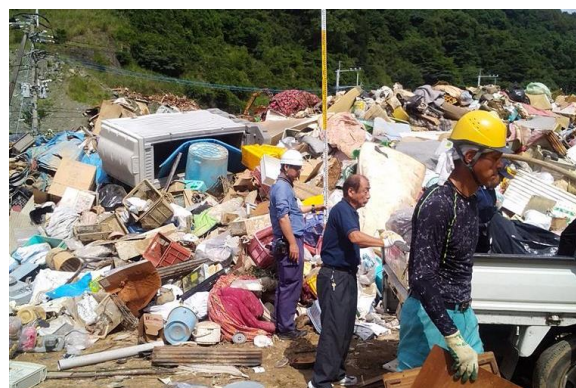
積上げ状況 約2.5m(7/15)
