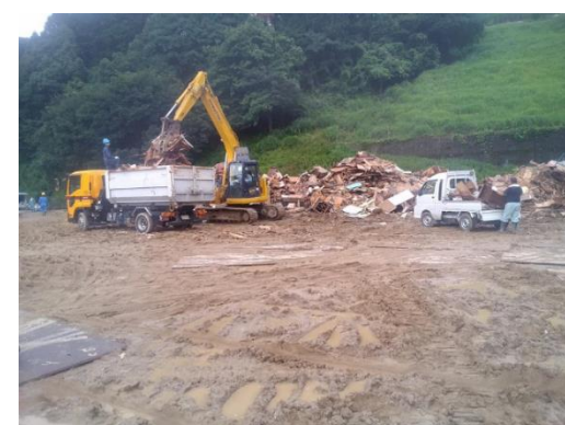
可燃物の搬出状況(7/12)
