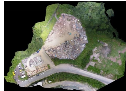
ドローンによる仮置場空撮画像 (7/16)
