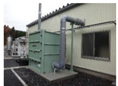
脱臭装置 （既設活性炭吸着塔移設）
