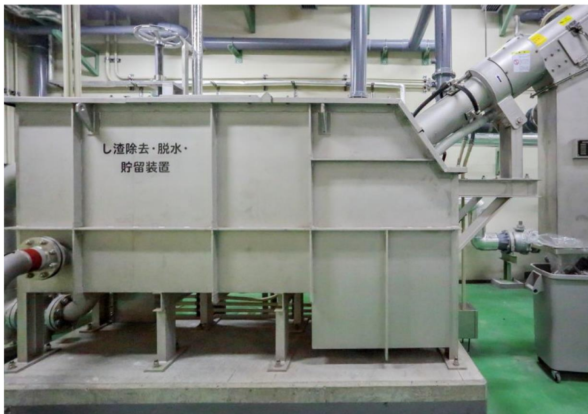
【ロータマットスクリーンの設置状況写真】
