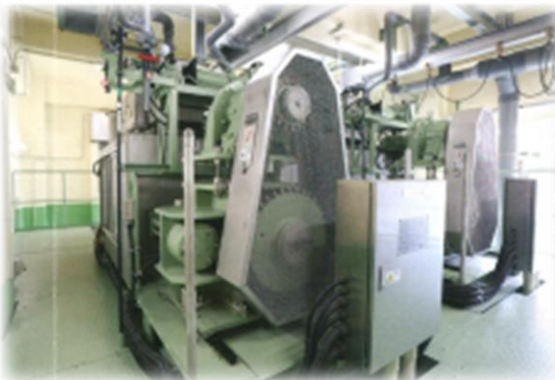
固液分離装置 (軸摺動式脱水機)
