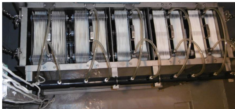
膜ユニット設置状況
