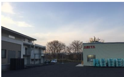
左：旧志津川浄化センター 右：バイオガス施設
