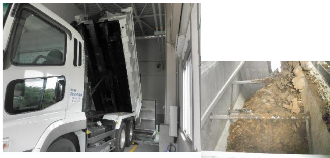
下水道汚泥受入状況
