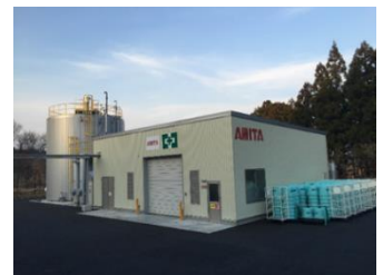
バイオガス施設
