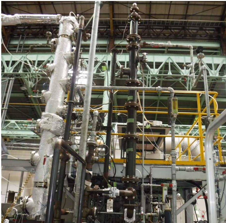
図 4-1-2 ベンチ試験ガス精製装置 外観写真
