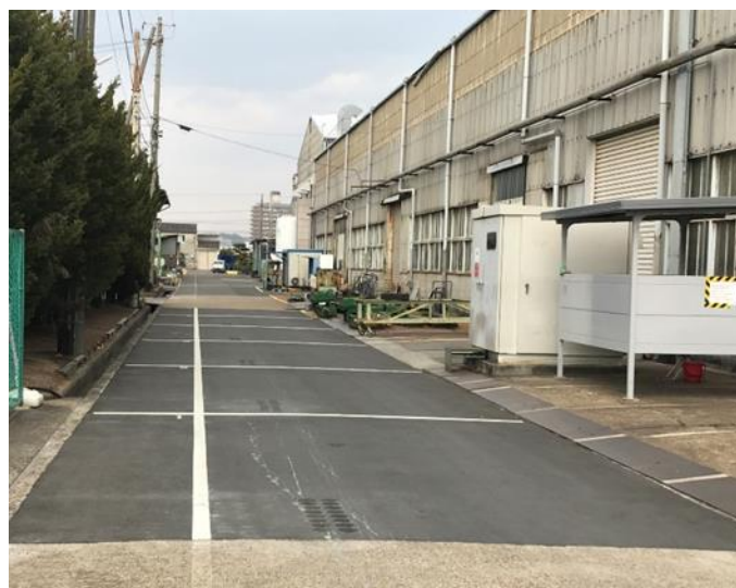
図 1.4.3-1 舗装後 5 ヶ月経過後した試験用道路
