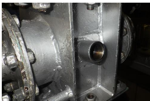
図 2.2.5-8 空気抜きバルブ
