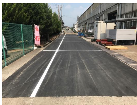
図 1.4.1-2 舗装後の試験用道路
