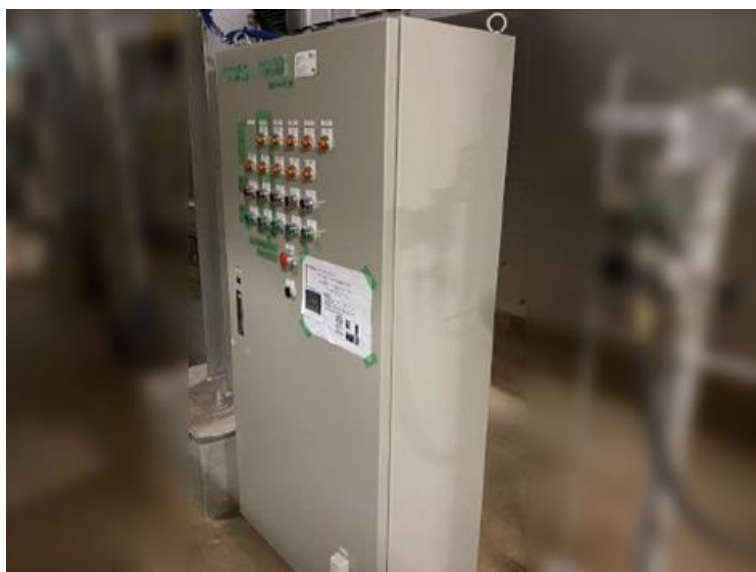
図 2-23 撤去工事前（令和元年度試験装置の制御盤）
