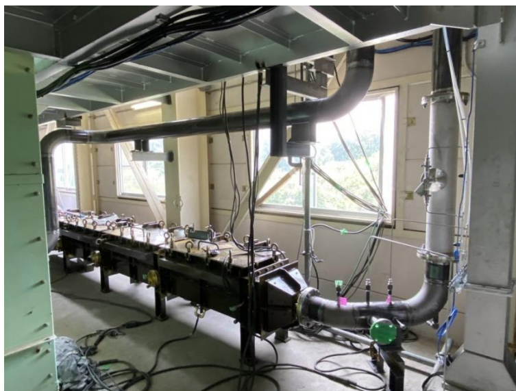
図 2-3 設置工事（上：制御盤、下：反応器）
