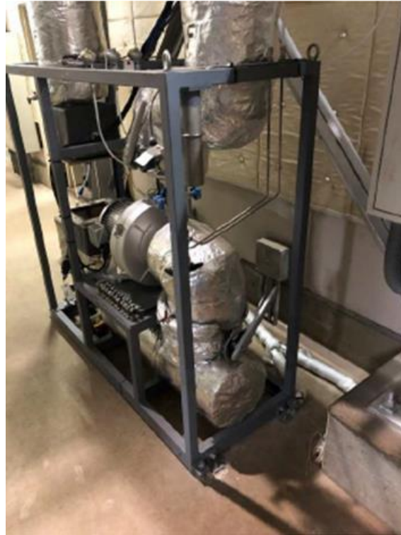
図 2-22 撤去工事前（令和元年度試験装置）
