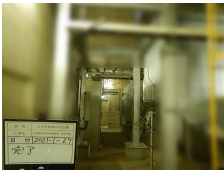
図 2-24 撤去工事後（令和元年度試験装置）
