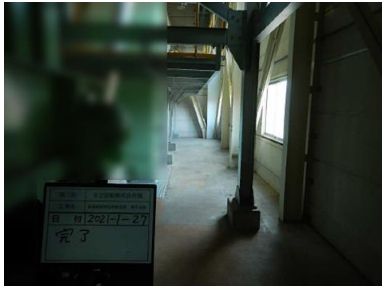
图 2-26 撤去工事後（令和 2 年度試験装置）
