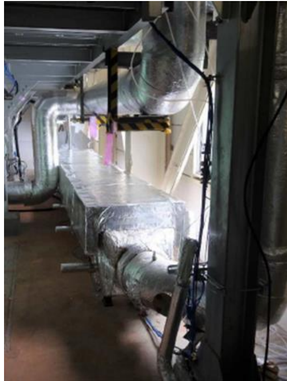
图 2-25 撤去工事前（令和 2 年度試験装置）
