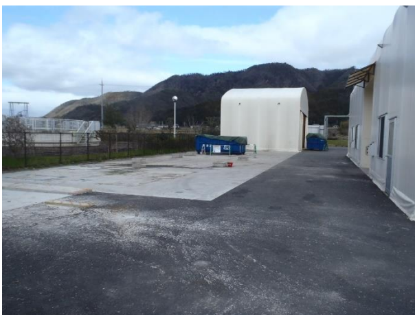
写真 2-5-1 屋外処理設備撤去
