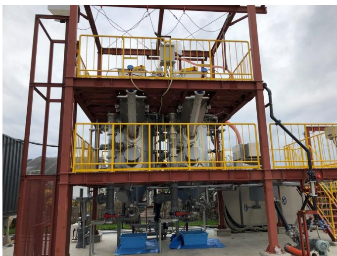
写真 2-2-1-6 メタン発酵設備
