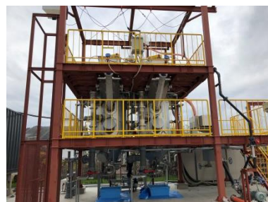
メタン発酵処理設備
