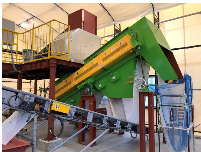
写真 2-2-4-1 破袋機＋選別機
