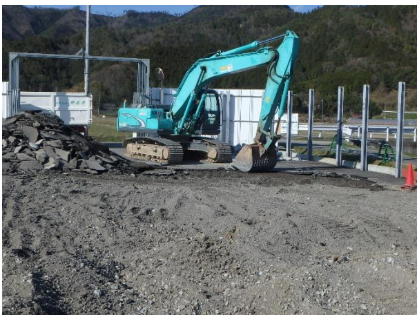
写真 2-5-3 土木建築設備撤去
