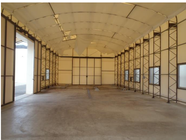
写真 2-5-2 作業棟内処理設備撤去
