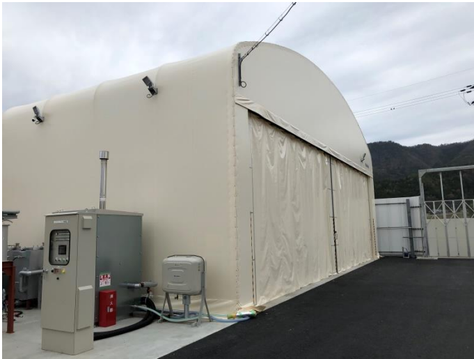
写真 2-2-1-8 倉庫棟(ごみヤード)
