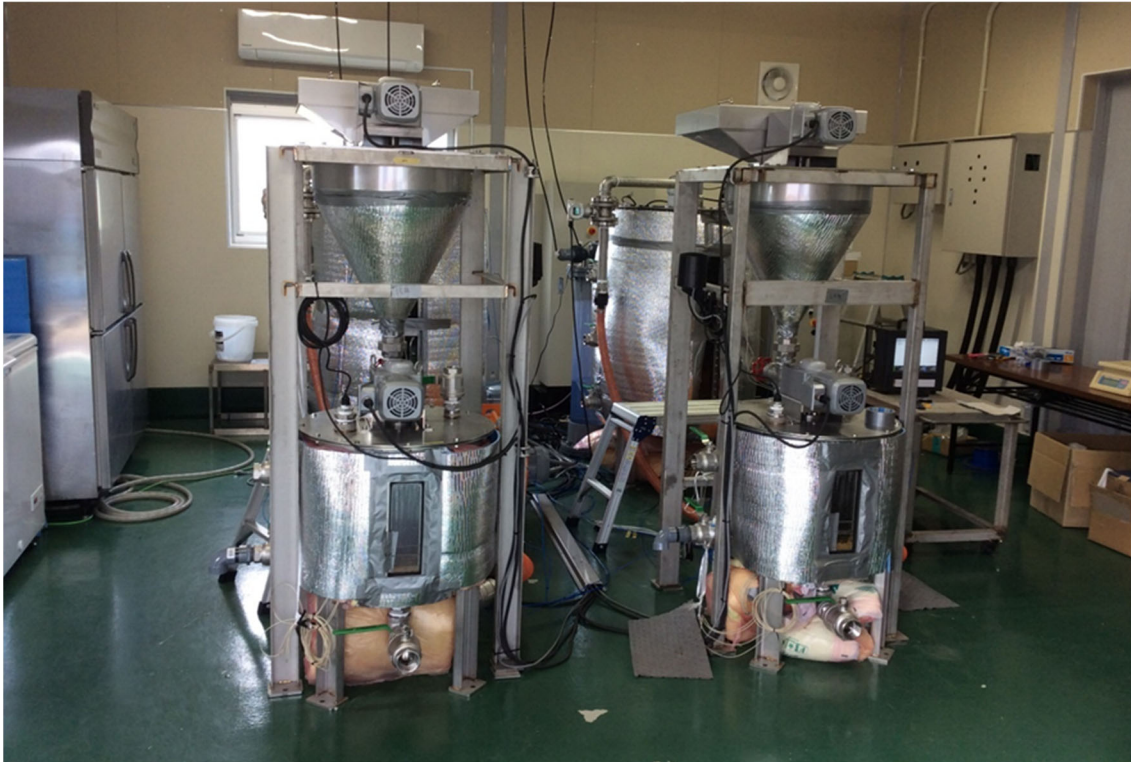
図 2-3-2 装置設置状況（断熱材巻き付け後）
