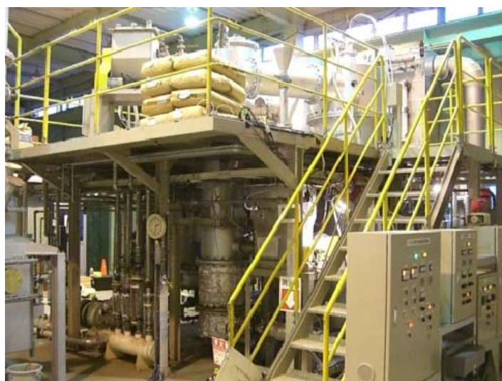
写真 3.1.2.2-1 当社ガス化設備の外観
