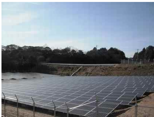
写真3 ながさきソーラーネット〔メガ〕三京発電所
