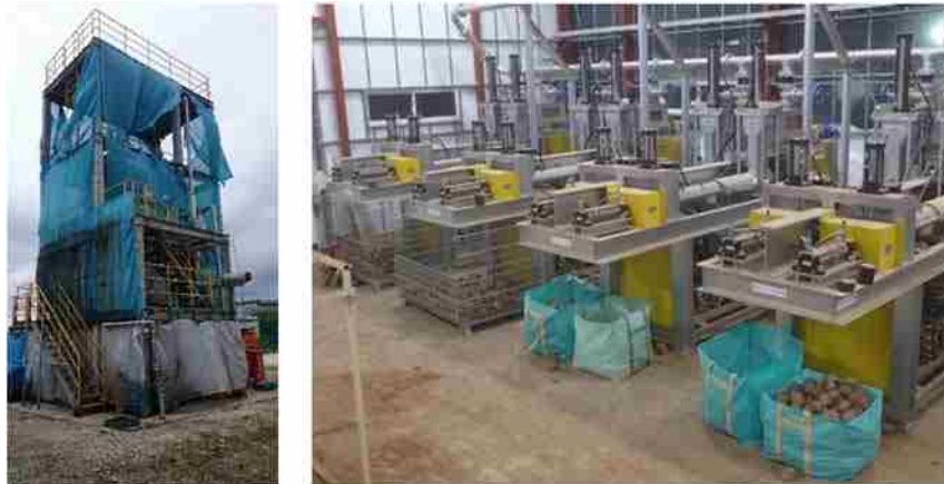
図表 1-2 各 BIC 製造設備の全景 (左：縦型製造設備、右：横型製造設備)
