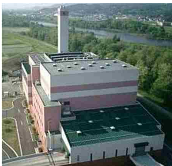
図表 1-14 盛岡・紫波地区環境施設組合 清掃センターごみ焼却施設
