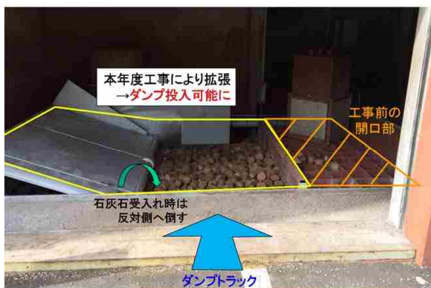
図表 2-4.3 工事後の開口部
