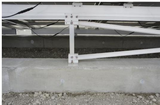
写真 5.2-6 基礎に取付ている架台
