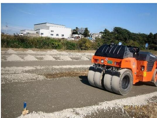
写真 5.2-3 タイヤローダーによる転圧作業
