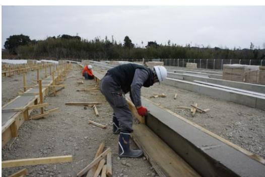
写真 5.2-5 コンクリート型枠外し
