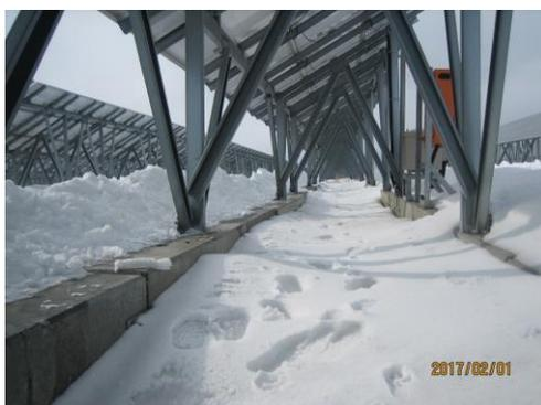
写真 5.1-16 凍上沈下が修復された基礎
