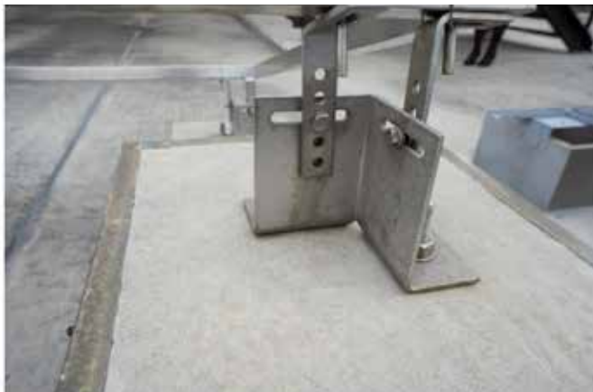
微調整可能な治具を設置
