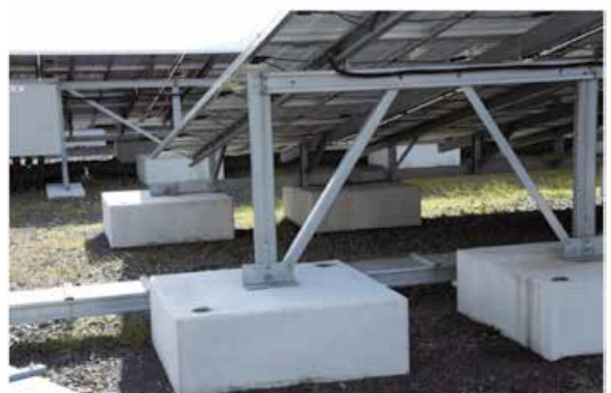
覆土への影響を避けるため置き基礎を採用
