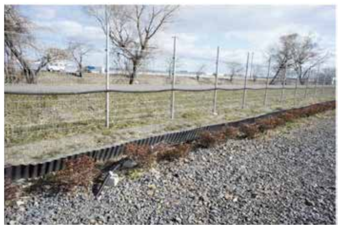
処分場の周囲を雨水誘導板を設置し樋管に雨水が流れるように工夫
