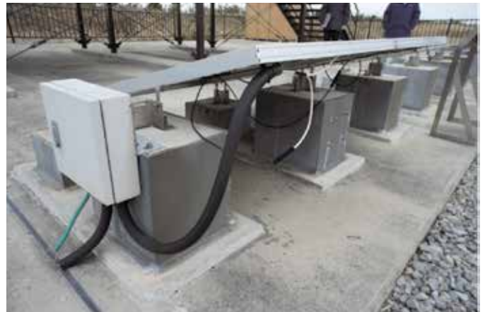
沈下に備えてパネルの位置を微調整できる治具を開発し使用
