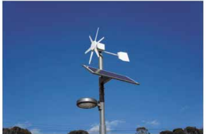
ハイブリッド防犯灯(3基)を設置
