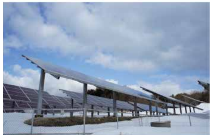
パネル設置場所の地盤強度と斜面傾斜に応じた基礎を採用
