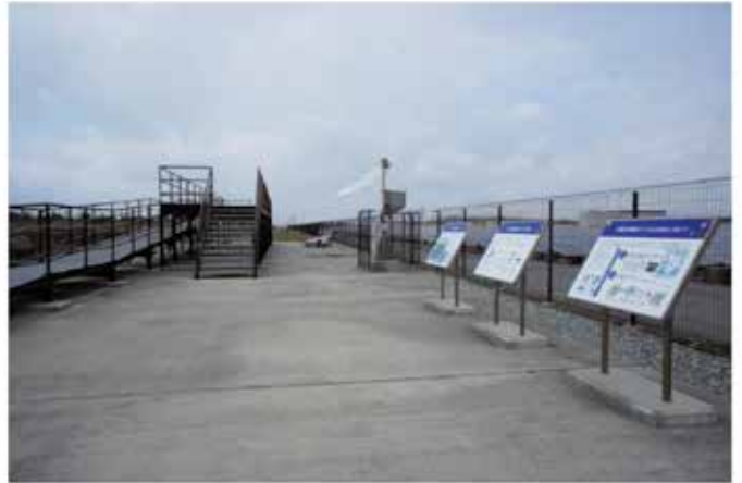
見学用の物見台と太陽光発電事業の概要を説明する看板を設置
