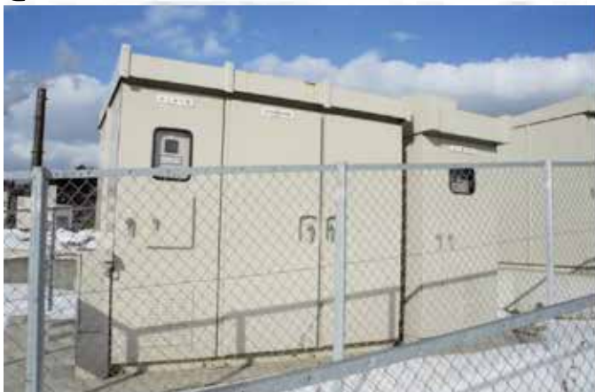
非常用電源を設置
